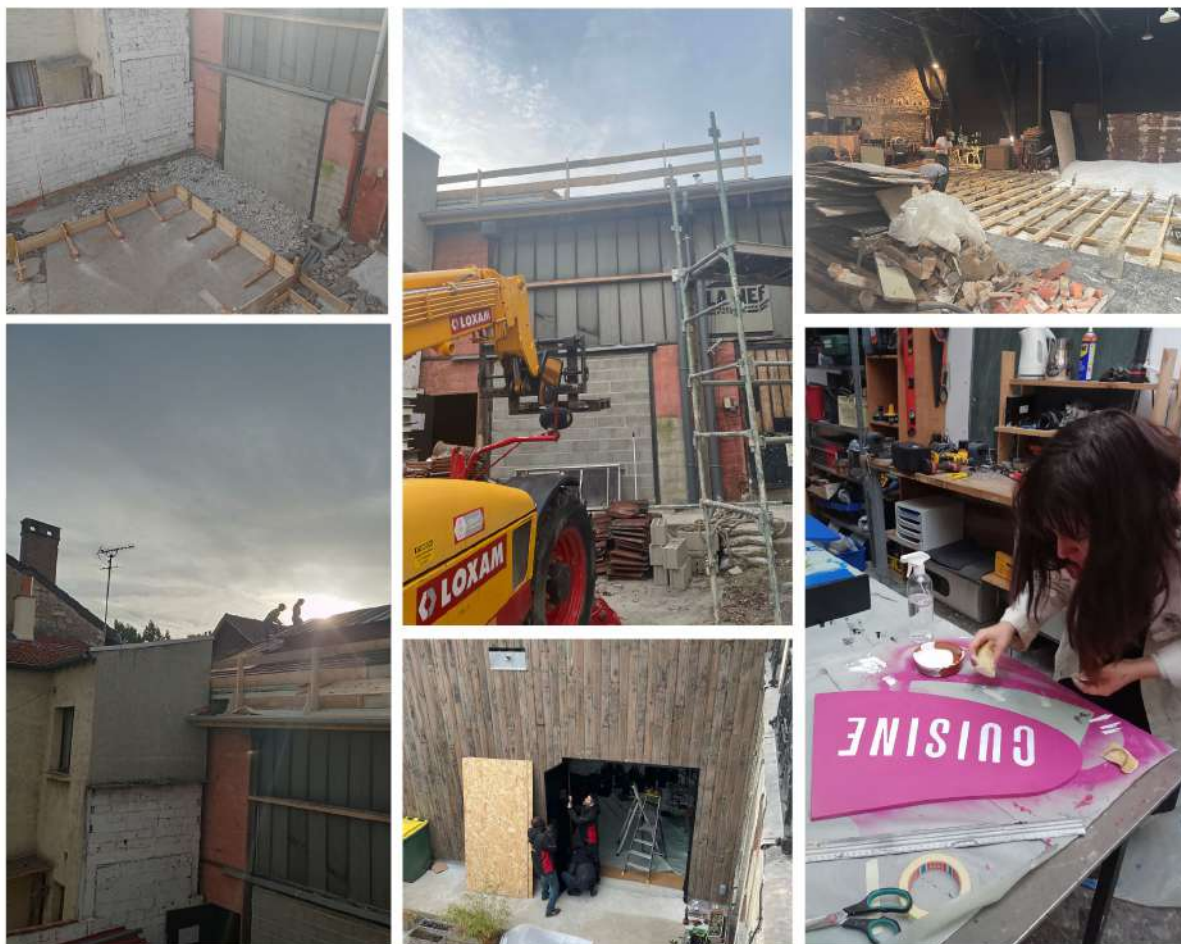
Bâtiment pendant la période de travaux
